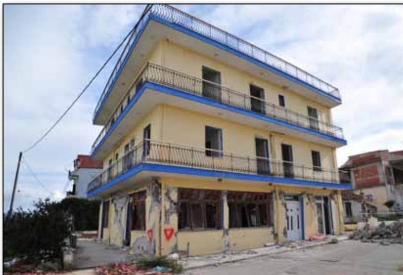
ΕΙΚΟΝΑ 5.1 Σήμανση από ειδικά κλιμάκια σε κτίριο στο Ληξούρι Κεφαλονιάς αμέσως μετά το σεισμό του 2014. Το παρόν κτίριο κρίθηκε κατεδαφιστέο λόγω της θέσης του πάνω σε οδικό άξονα.
