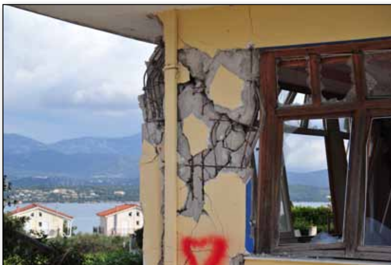
ΕΙΚΟΝΑ 5.1 Σήμανση από ειδικά κλιμάκια σε κτίριο στο Ληξούρι Κεφαλονιάς αμέσως μετά το σεισμό του 2014. Το παρόν κτίριο κρίθηκε κατεδαφιστέο λόγω της θέσης του πάνω σε οδικό άξονα.
