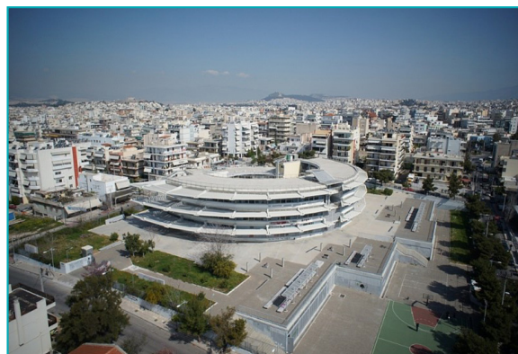
Μετασκευή κτηρίου στον Άγιο Δημήτριο. © Δήμος Αγίου Δημητρίου
